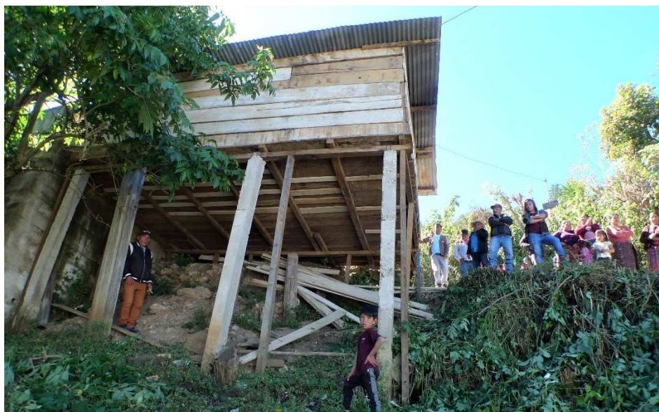
Fig.18.. Première option d'implantation du poste de santé, en lieu et place de cette structure en bois.
